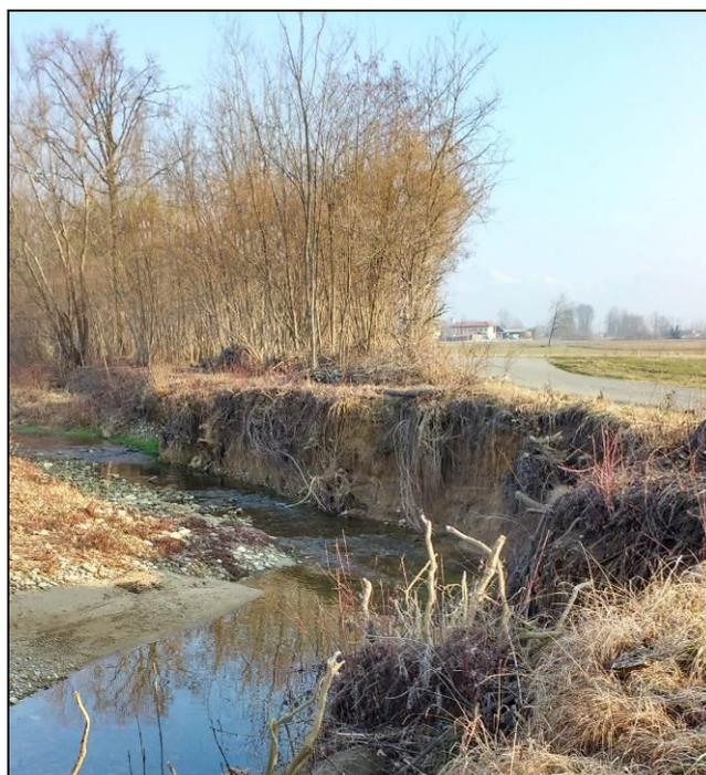
**Figura 3 – Evidente erosione di sponda che induce che compromette la sicurezza del tratto stradale.**
