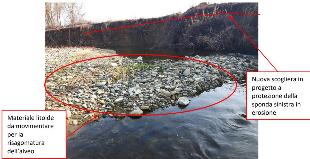
**Figura 2 – Intervento di monte – sponda sinistra soggetta ad erosione e materiale depositato in alveo.**
