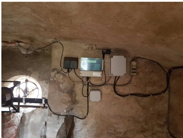
Da questo nuovo dispositivo dovrà essere alimentato il nuovo quadro elettrico di protezione che dovrà essere installato al piano terra, mediante cavo FG16OR16 1(3G2,5), che dovrà essere posato all'interno di nuove vie cavo da prevedere con il presente intervento.
