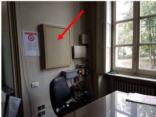
Da questo nuovo dispositivo dovrà essere alimentato il nuovo quadro elettrico di protezione che dovrà essere installato a lato del quadro generale, per l'alimentazione e la protezione delle nuove apparecchiature previste.
