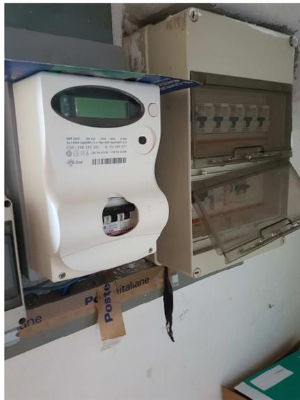
Da questo nuovo dispositivo dovrà essere alimentato il nuovo quadro elettrico di protezione che dovrà essere installato nel sottotetto dell'edificio, mediante cavo FG16OR16 1(3G2,5), che dovrà essere posato all'interno di nuove vie cavo da prevedere con il presente intervento.
