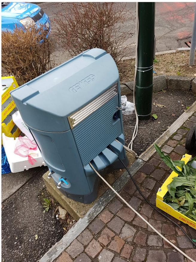
Da questo nuovo dispositivo dovrà essere alimentato il nuovo quadro elettrico di protezione che dovrà essere installato sul nuovo palo previsto, mediante cavo FG16OR16 1(3G2,5), che dovrà essere posato all'interno di nuovi cavidotti interrati da prevedere con il presente intervento.
