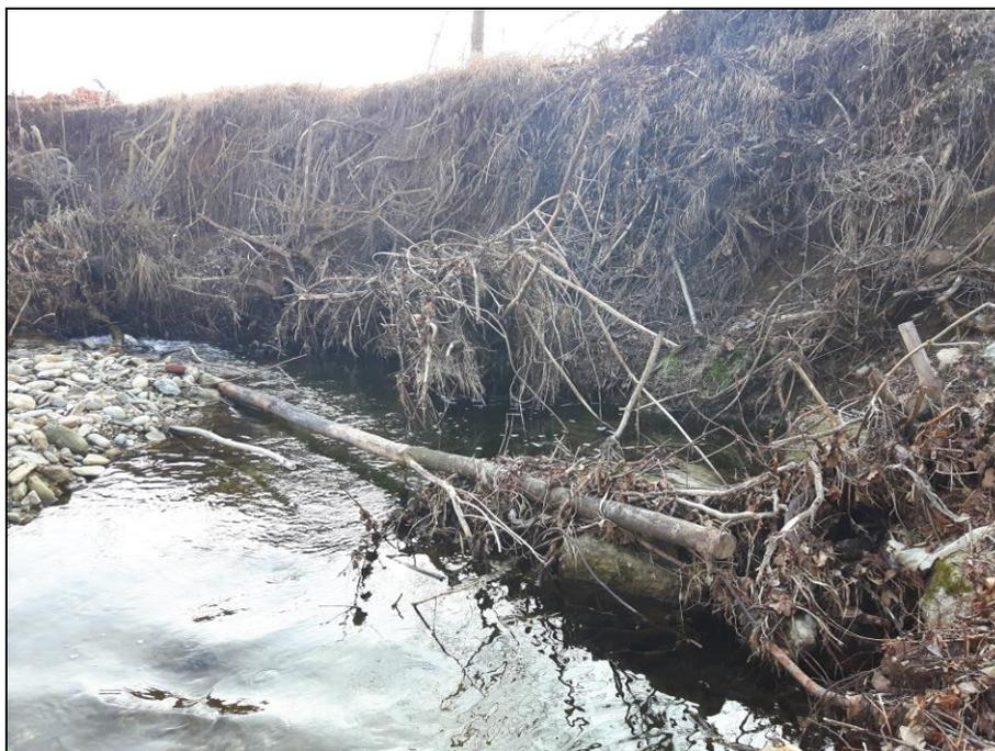
*Foto 1 – Intervento di monte – Sponda sinistra in erosione dove si prevede di realizzare la nuova scogliera.*
