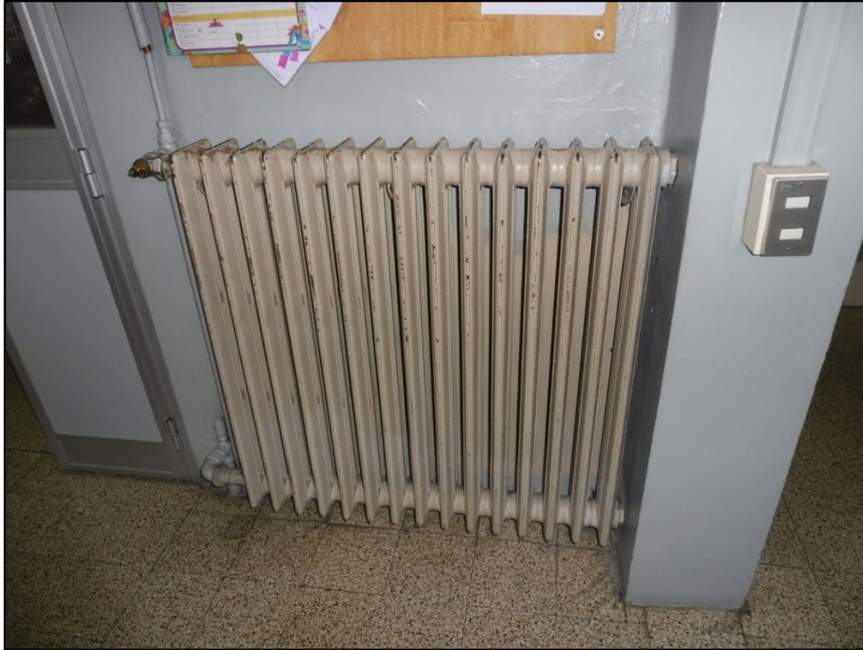
Figura 9: Radiatore in ghisa a colonne
