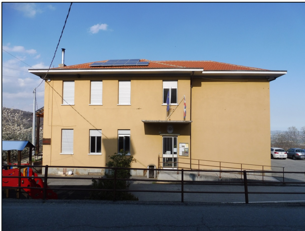
Figura 1: Sito di intervento – Prospetto SUD-OVEST
