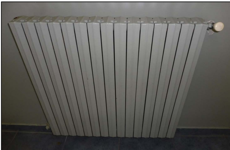
Figura 10: Radiatore in ghisa a piastre
