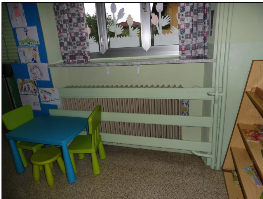
Figura 6: Dettaglio distribuzione a colonne montanti
